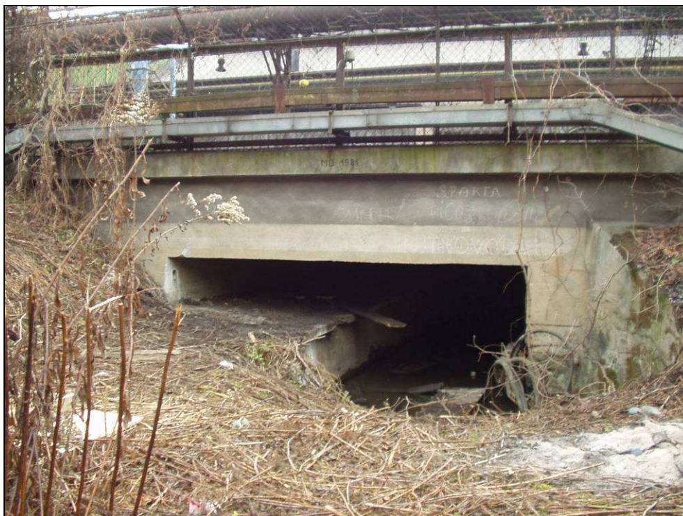
Obr. č. 1 - pohled na objekt zprava. U opěry Praha je patrný kabelovod
